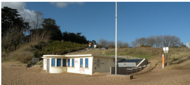
Figure 105 : Le poste de secours
