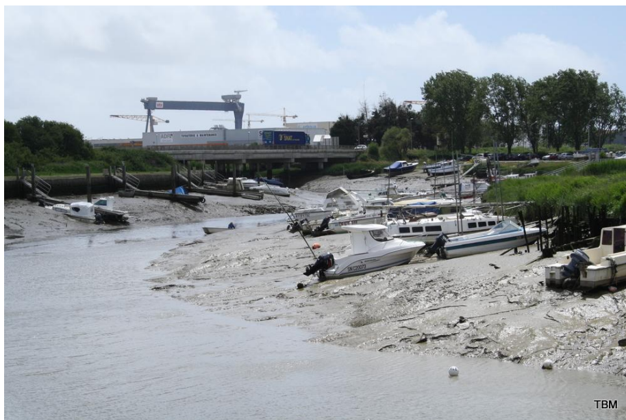
Figure 37 : Brivet et vasières en aval de l'écluse
