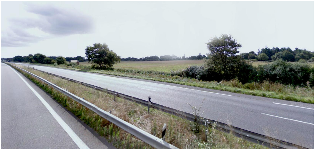
Figure 151 : depuis la RN171 sens St-Nazaire/Nantes - Existant
