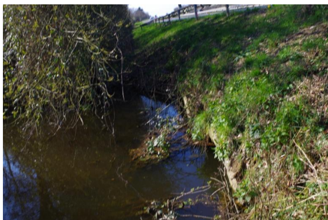
Figure 176 : point de rejet des eaux pluviales du projet dans le milieu récepteur (ECR)
