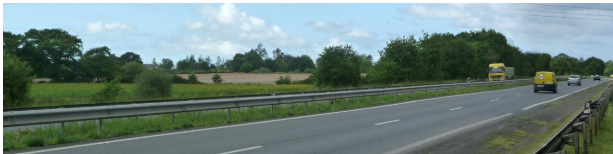
Figure 155 : depuis la RN171 sens Nantes/St-Nazaire - Existant
